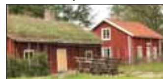
Komministerbostället Råshult Södregård på väg att bli vetenskapligt världsarv.
