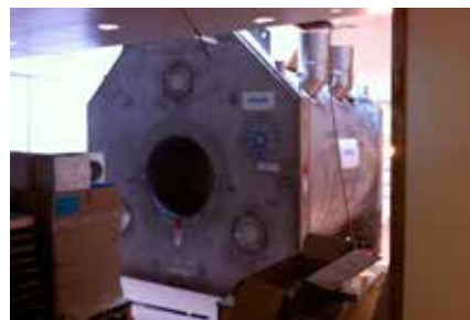
Fig 3. Magneterna på plats direkt efter inlyftet. Magnetens dimensioner (lxbxh) är c:a 3,3x2,9x3,5 m och längden på primärspolens lindning är c:a 560 km.
