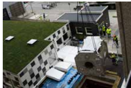
Fig 2. Inlyftet av den 44 ton tunga magneten ägde rum den 3 december 2014.
